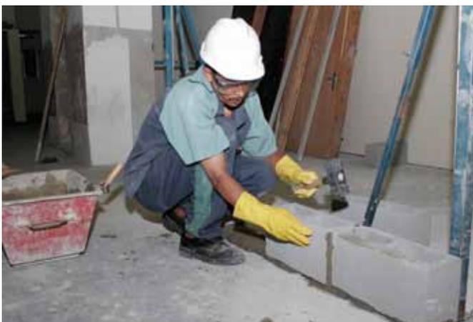
8. Depois de assentar cada tijolo ou bloco, retire o excesso de argamassa com a colher de pedreiro, procurando deixar a parede o mais uniforme possível.
