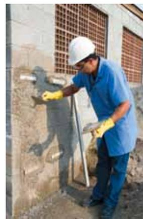
Com as taliscas prontas para servir de guia, você começará a colocação da argamassa. Esse processo se dá aos poucos, em uma parte da parede de cada vez.
